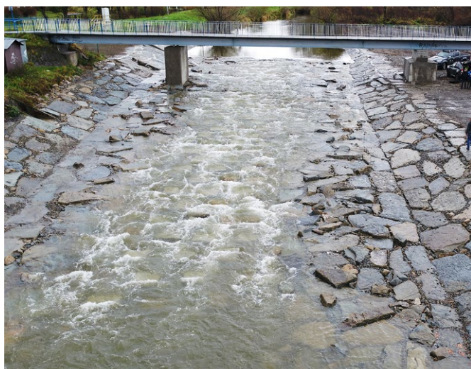
Przepławka typu kamienna rampa w Jedliczu po realizacji
