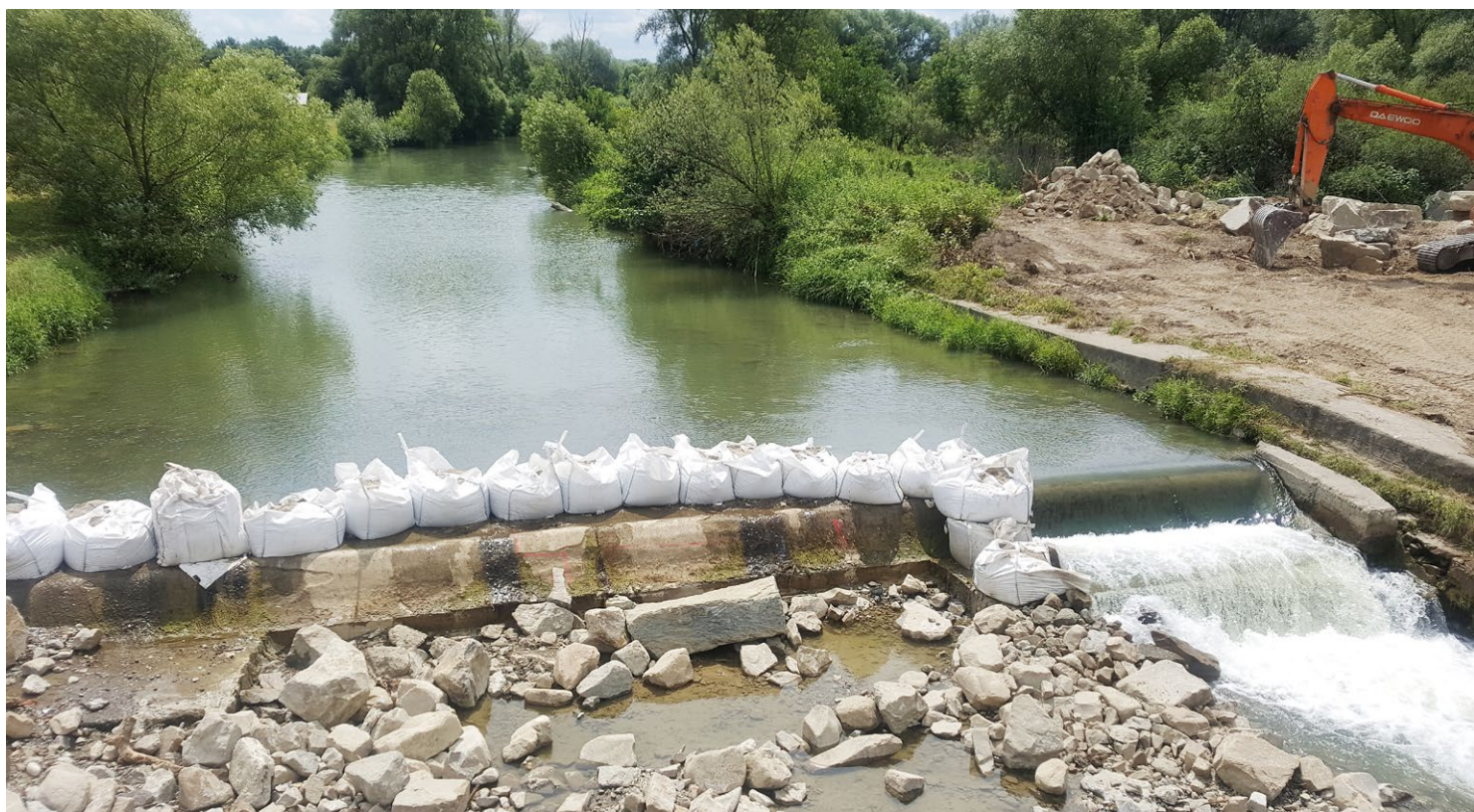
Zabezpieczenie mąceniem big bagami w Jedliczu
