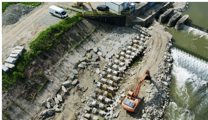
Układanie kamiennej rampy poniżej przeławki technicznej
