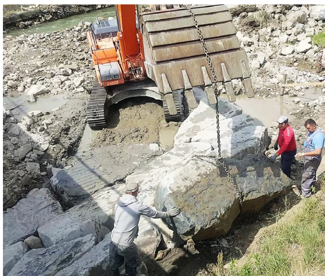
Układanie kilkutonowych głazów
