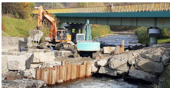
Plac budowy wydzielony za pomocą ścianki szczelnej, droga dojazdowa ułożona na stalowych rurach
