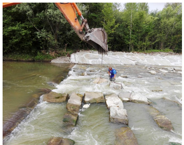
Korekta górnej części przepławki – dokładanie głazów
