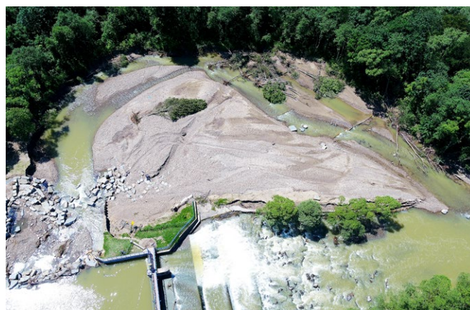
Widok zniszczonej przepławki po powodzi w czerwcu 2020 r.
