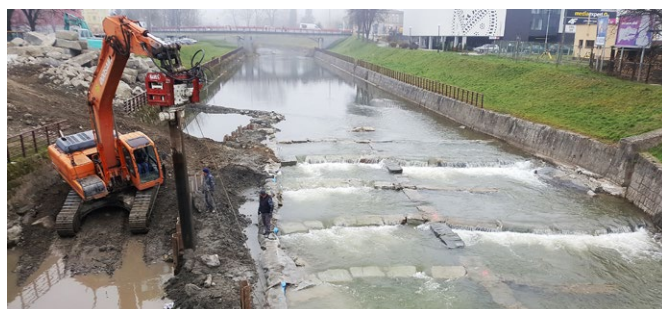
↓ Wbijanie ścianki szczelnej typu Larsen
