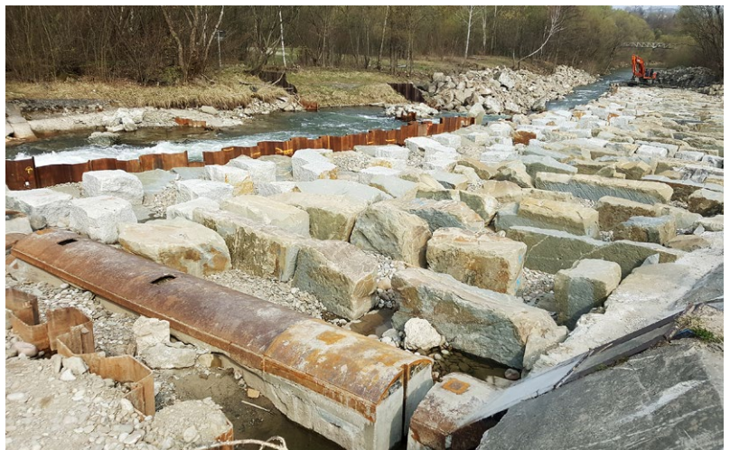
Układanie przepławki kaskadowej przy prawym brzegu
