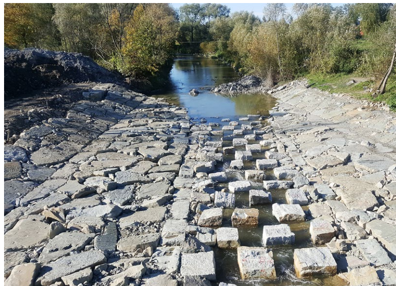
Układ kamieni w przepławce poniżej mostu
