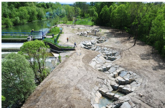
Układ kamieni w przepławce
