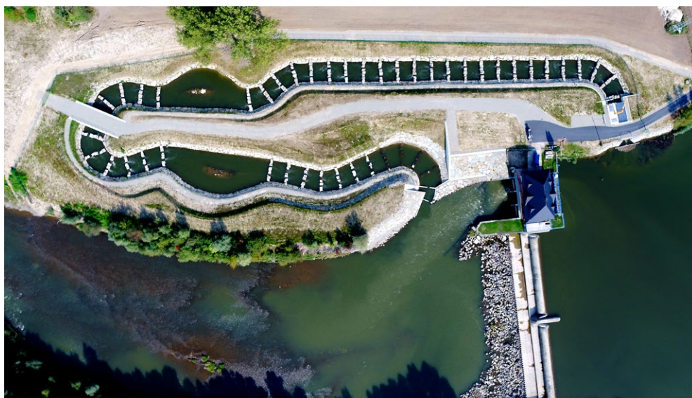
Przepławka typu kanał obejścia jazu w Mokrzu po realizacji
